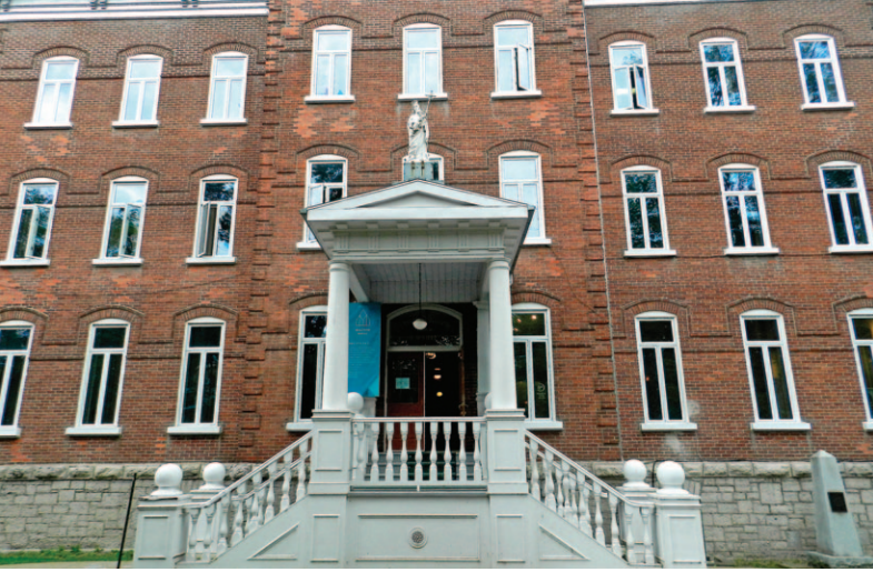
L'ancienne résidence des Petites Franciscaines de Marie à Baie-Saint-Paul.
